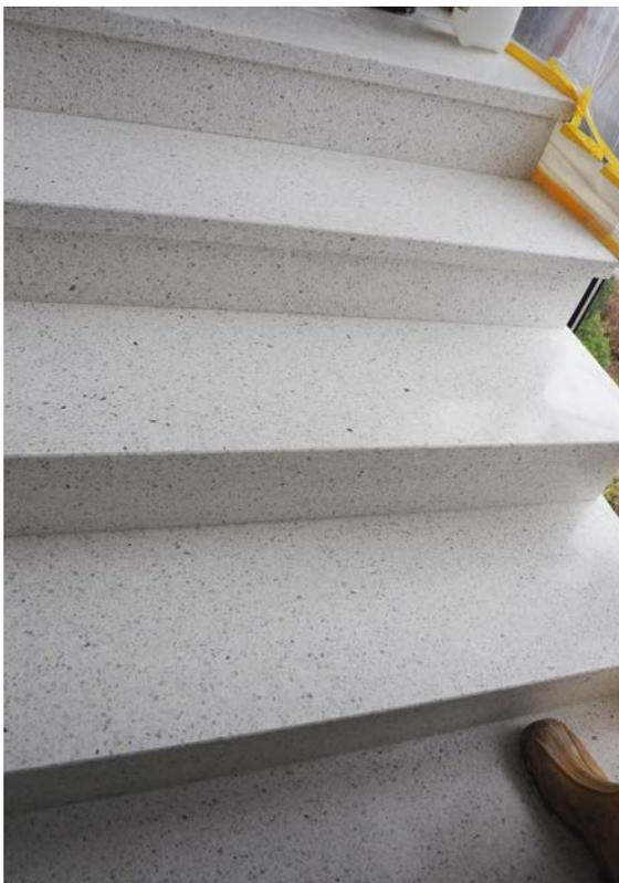
Für noch besseren Glanzeffekt: Nach Rücksprache mit Andree Biermann erhielten die Treppenstufen eine Handmaschinen-Zusatzbehandlung mit einer Reinigungsemulsion aufpoliert mit einem weißen Pad
