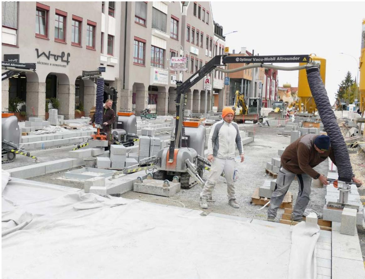
Präzise und wirtschaftliche Verlegung schwerer Granitblöcke: Mit Hilfe der Vakuumausleger an den Pflastermaschinen können Markus Tuscher (r.) und seine Leute leichter und schneller arbeiten
