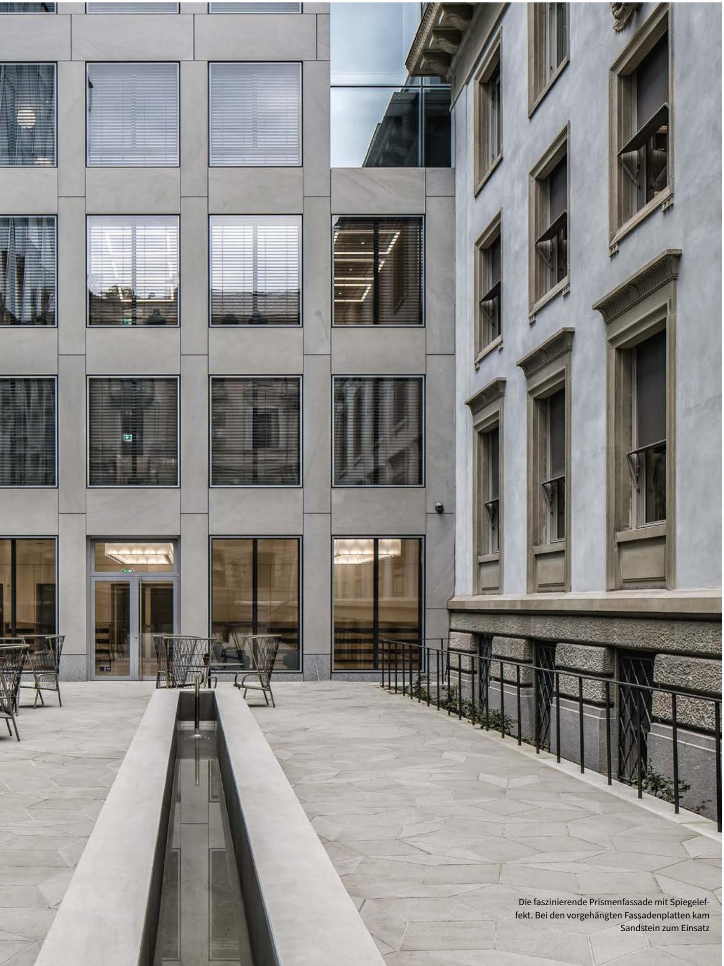
Die faszinierende Prismenfassade mit Spiegeleffekt. Bei den vorgehängten Fassadenplatten kam Sandstein zum Einsatz
