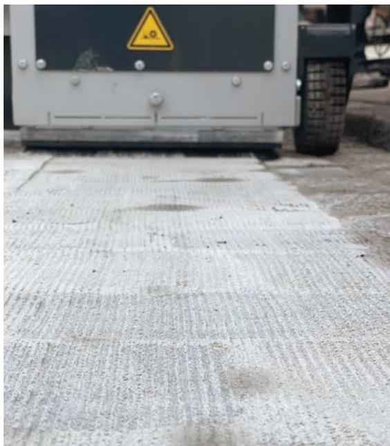
Ebnet Bestands-Pflastersteine barrierefrei ein: Diamantschneidemaschine mit Diamantflächensägen
