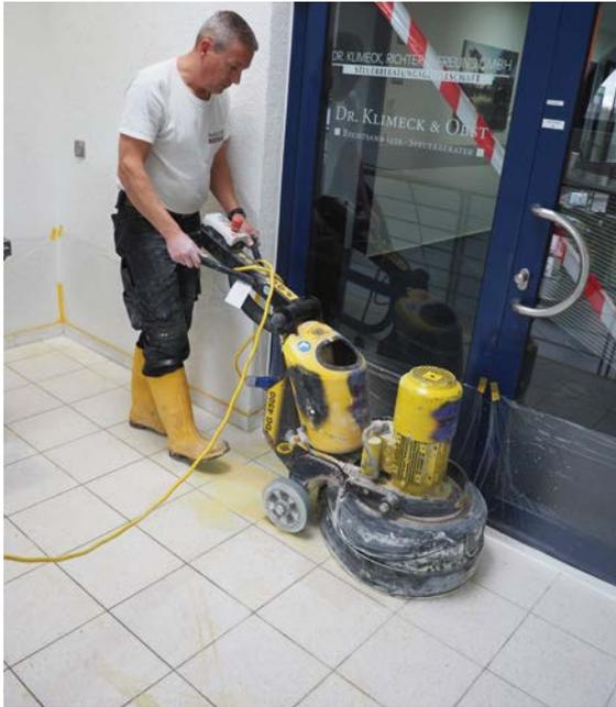
Michael Mertens bei der Maschinenarbeit: In mehreren Schleifgängen verlieh er dem Microterrazzo einen glanzvollen Planschliff.
