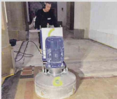
Neuer Glanz für alten Boden: Mit der Drei-Scheiben-Schleifmaschine von Blastrac bearbeitet Mertens den Naturstein in einer Kirche in Neuss
