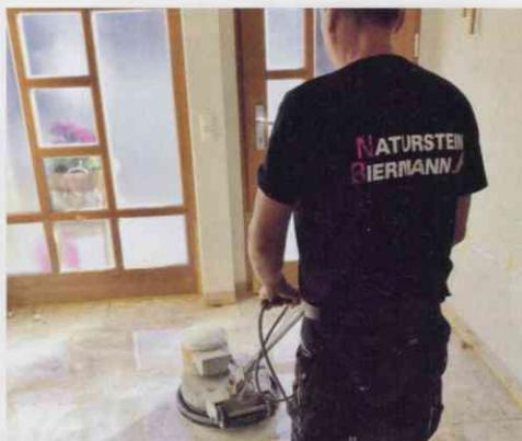
Obermonteur Michael Mertens beim Oberflächen-Systemschliff mit einer Einscheiben-Schleifmaschine und Pad im Eingang eines Wohnhauses
